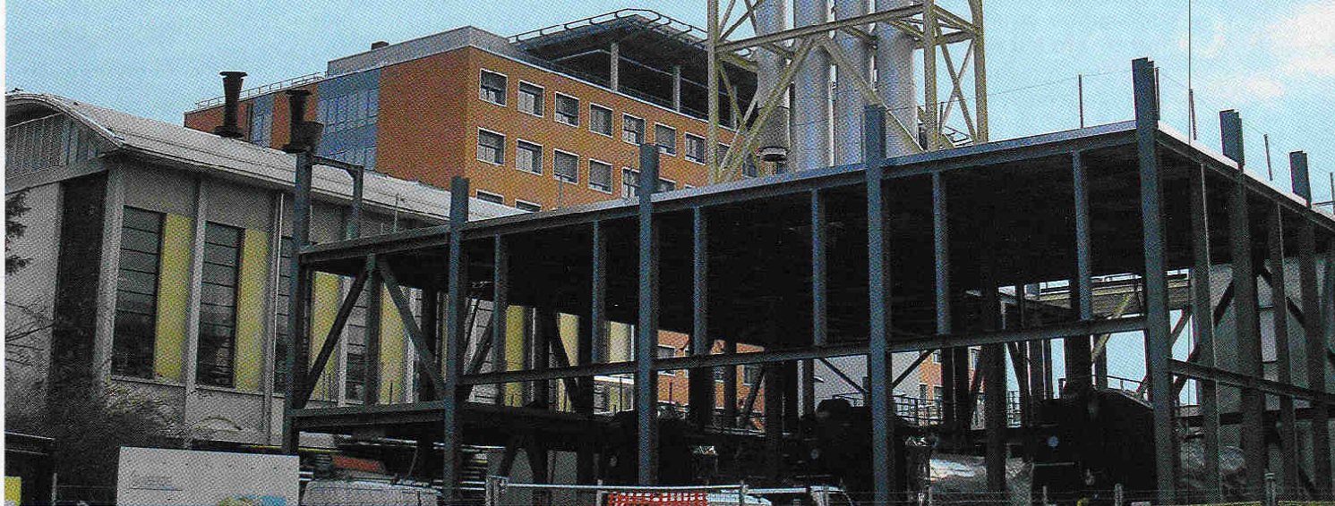
CENTRALE IN COSTRUZIONE
